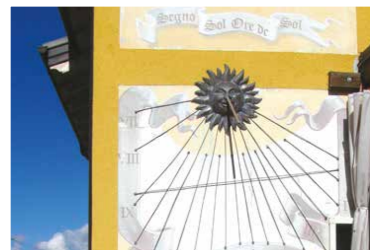
Il cappotto dei lavori del 2015 incornicia la meridiana.
