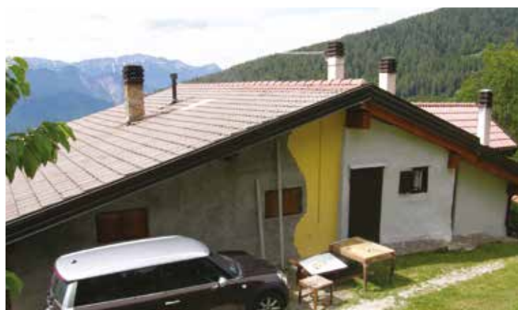
Parete nord della baita
